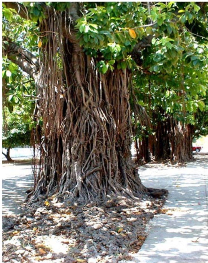
Figura 10: Calle con ejemplares de Ficus sembrados en su sección, obsérvese conflictos con los pavimentos. Fuente: tomada por los autores.
